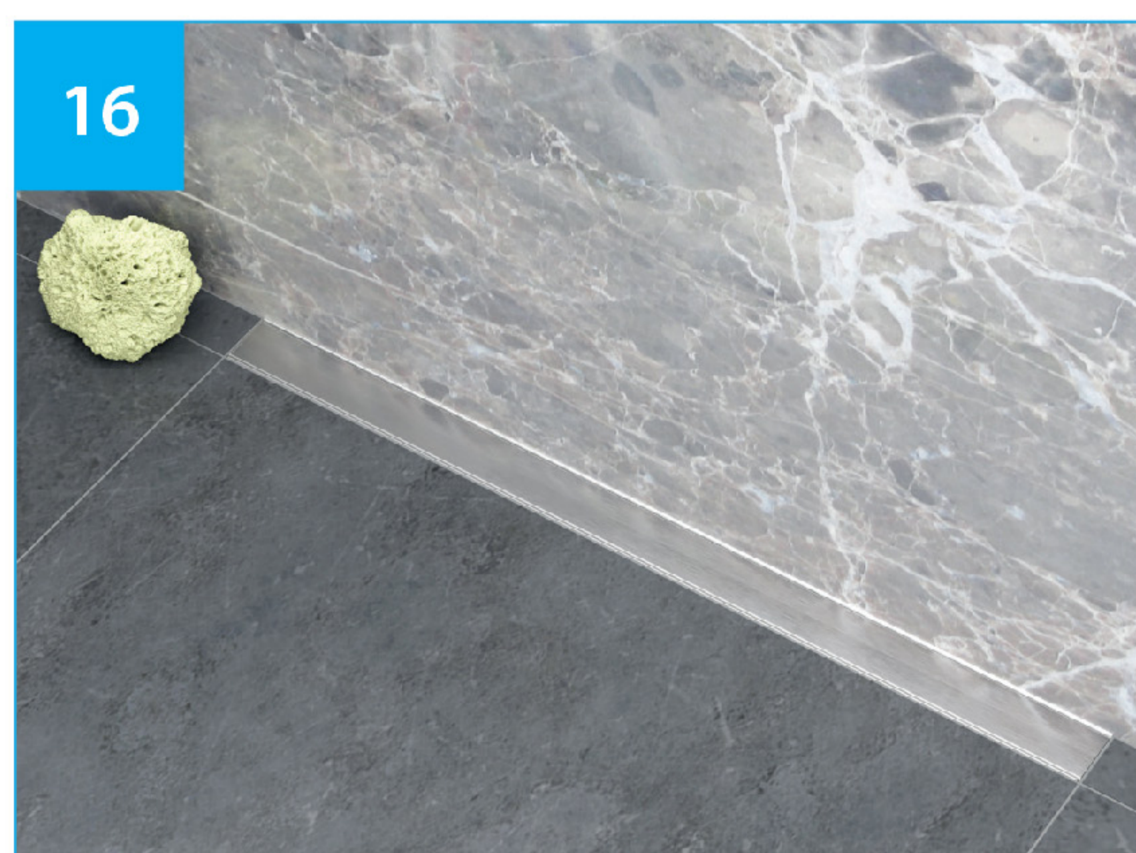
16. Abschließend, setzen Sie die Duschrinnen-Abdeckung in den Grundkörper der Duschrinne ein. Finally, place the cover into the shower drain.
