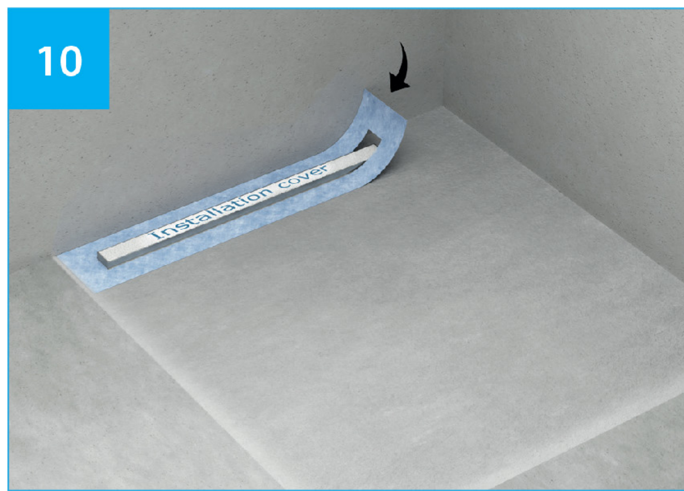
10. Befestigen Sie, wie in der Abbildung, die selbstklebende Dichtmanchette. Attach the self-adhesive sealing sleeve.
